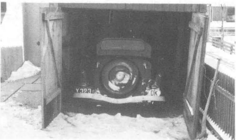
7'eren i dens garage gennem mere end 40 år.
